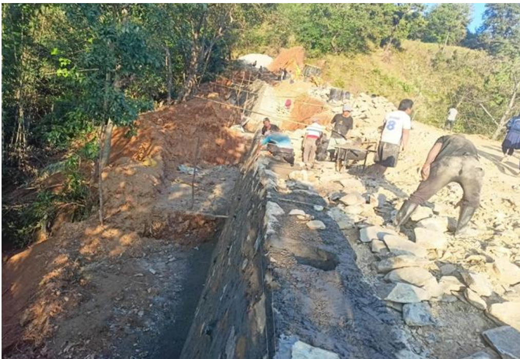
निर्माण कार्य भईरहेको सामरी मैबल सडक
